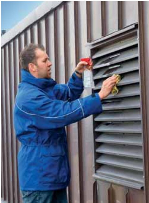
Reinigung einer Außenluftansaugöffnung
