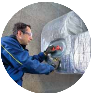
Öffnen einer Inspektionsöffnung zur Kontrolle der Luftleitung
