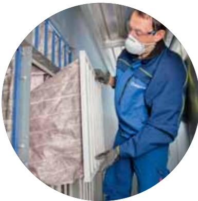
Ausbau eines gebrauchten Luftfilters
