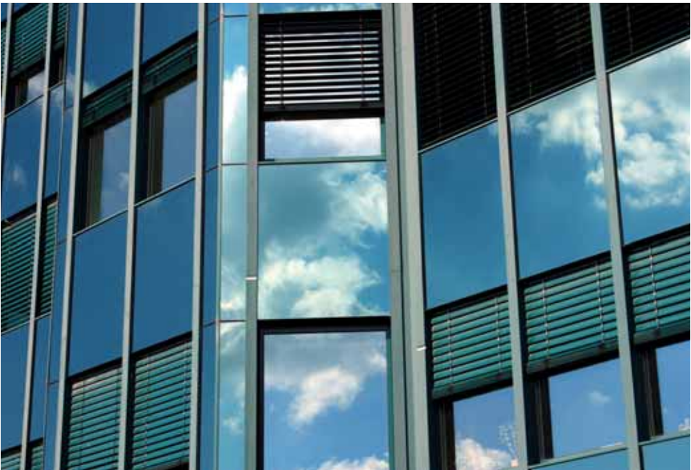
Sonnenschutzvorrichtung an einem Bürogebäude
