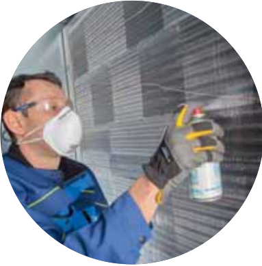
Desinfizieren eines Lufterhitzers
