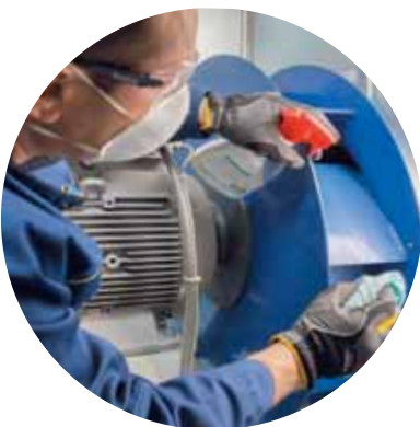
Reinigung eines Ventilators
